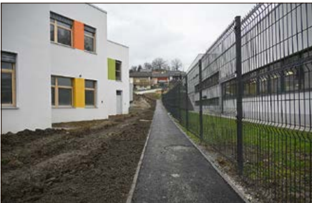
Ob šoli poteka pešpot, ki je sicer odprta, hkrati pa je pomembno opozoriti, da neposredno ob poti potekajo ureditvena dela okolice.
