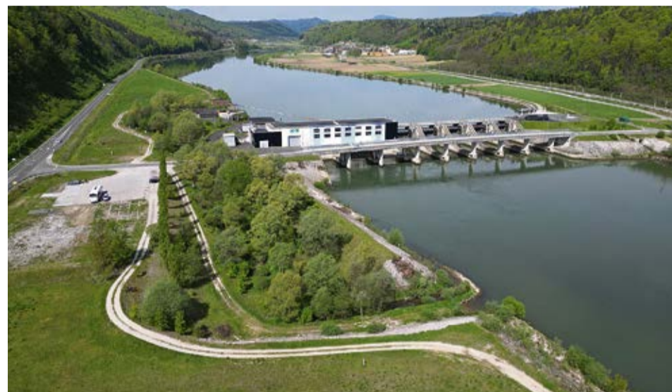
Slika 2: HE Arto – Blanca z ribjo stezo, vir: Goran Rovar
