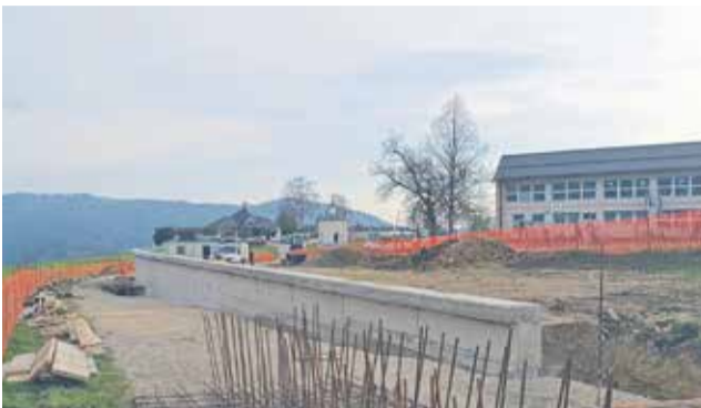
Gradnja opornega zidu
