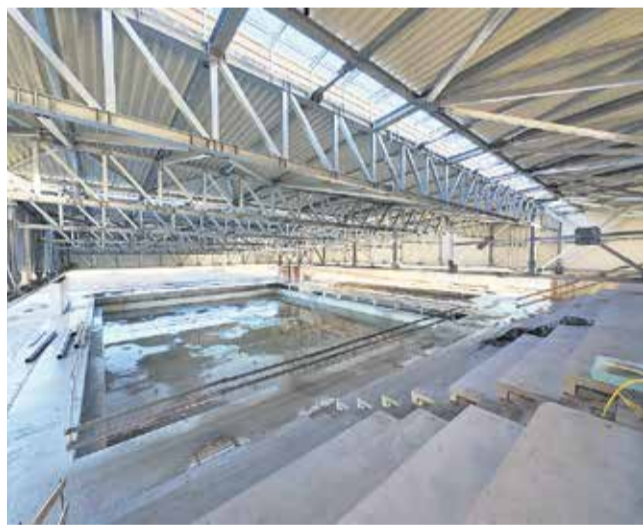
Krško – gradnja bazena
