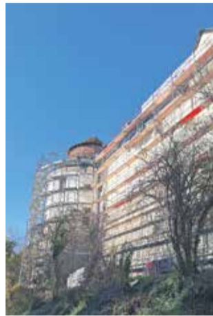
Potek obnove JZ-stolpa brežiškega gradu
