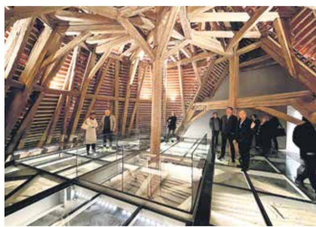
Stekleni pod razkriva leseno konstrukcijo.
