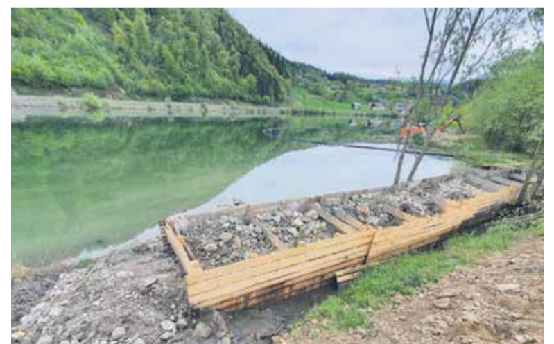
Uporaba sedimenta kot gradbenega materiala za stabilizacijo brežin s kaštami
