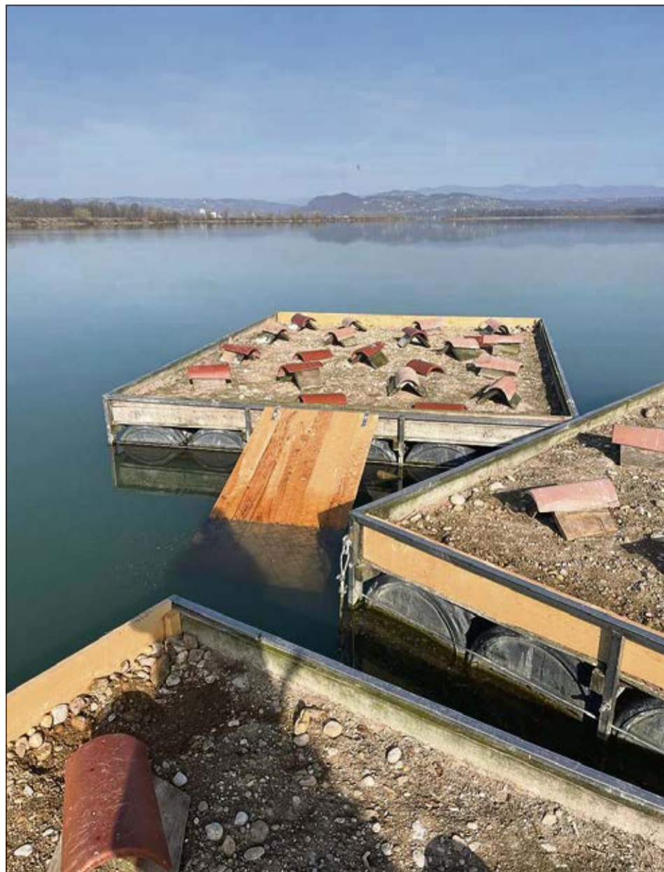
Na gnezdilnih splavih smo stare dostopne rampe nadomestili z novimi. (vir: arhiv HESS)
