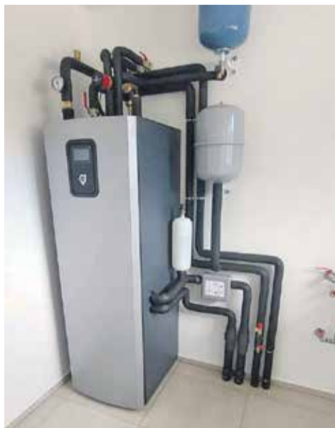
Geotermalna toplotna črpalka Thermia po končani montaži
