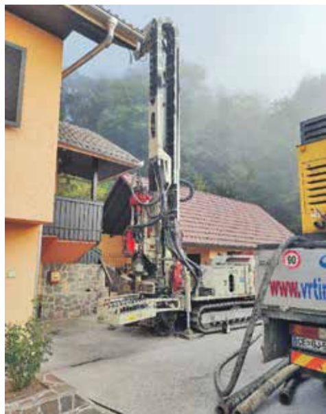
Izvedba 120-metrške geosonde v Brestanici, tik ob objektu
