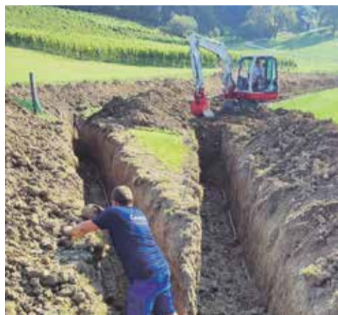
Izvedba horizontalnega zemeljskega kolektorja
