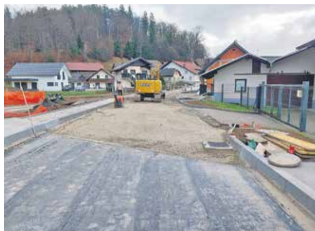
Most v Pijavica pred asfaltacijo
