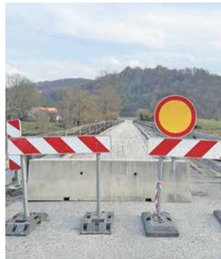
Zapora mostu traja že od novembra lani.
