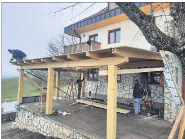
Ob Tončkovem domu na Lisci poteka obnova nadstreška.
