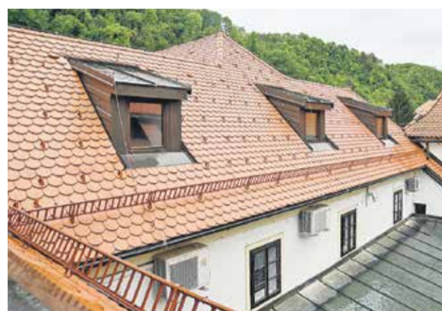
Dela so obsegala celovito sanacijo strehe, v okviru katere je bila izvedena menjava kritine ter kleparska dela z ureditvijo žlebov.
