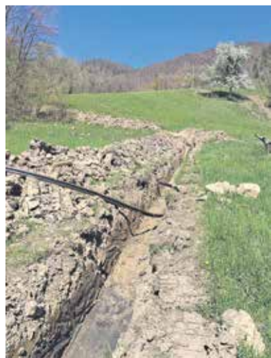
Gradnja povezovalnega vodovoda Loka–Račica
