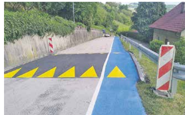
Zaradi prostorskih omejitev klasičen pločnik ni bil mogoč, zato je urejen pas za pešce na vozišču ter ukrepi za umirjanje prometa.
