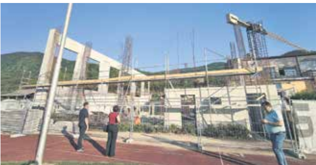
Po seji so si šli svetniki še ogledat gradbišče nove telovadnice (na fotografiji) in vrtca.
