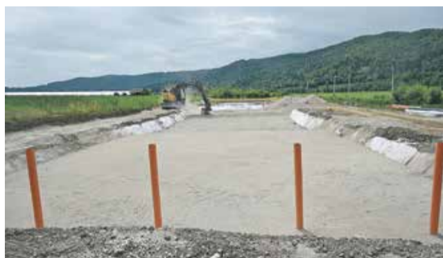
Pri železniški postaji nastaja rastlinska čistilna naprava.
