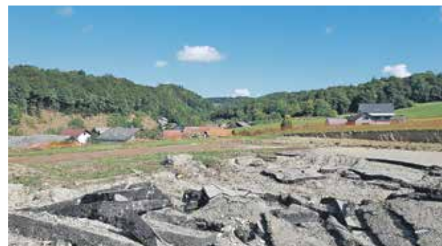
Zgornji ustroj starega asfaltne igrišča je odstranjen.
