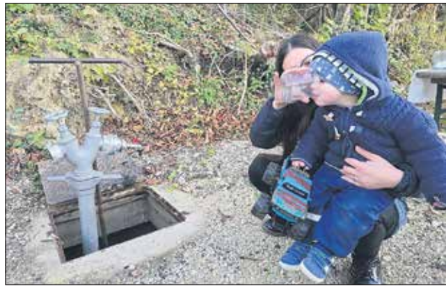
Uporabniki vodovoda Vrba-Vrtača so še kot zadnji v občini prišli do pitne vode.
