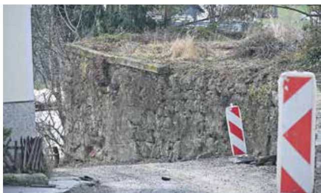
Sanacija kamnitega zidu v središču Loke pri Zidanem Mostu
