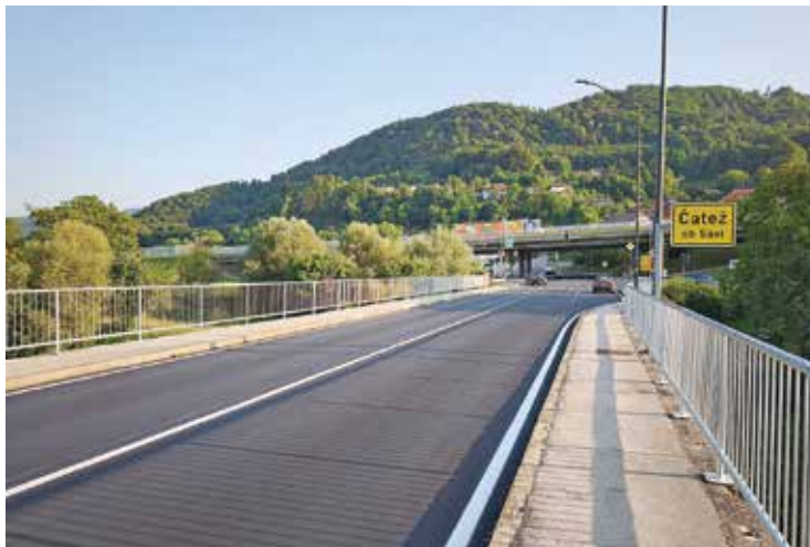
Na prometno zelo obremenjenem mostu na Čatežu ob Savi so pred kratkim zamenjali dotrajano ograjo in preplastili cestišče.
