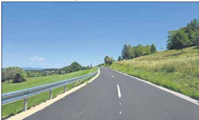
Obnovljena cesta od Kostanjevice proti Podbočju
