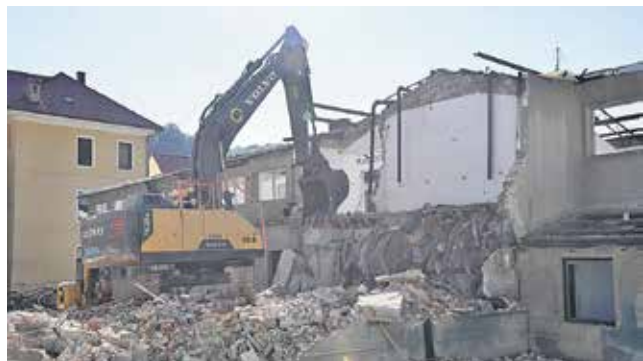
Na območju bodoče Osnovne šole dr. Mihajla Rostoharja potekajo rušitvena dela.
