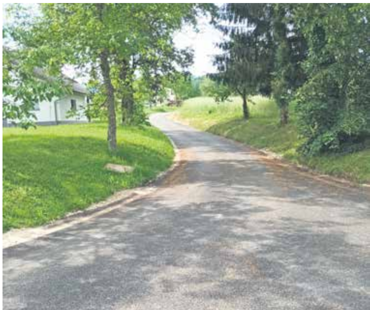
Obnovljena občinska cesta na Dolnji Prekopi – Jordan
