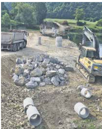
Gradbišče novega mostu
