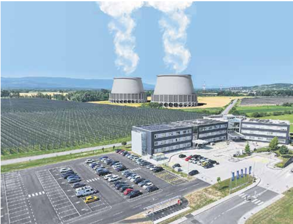
Stolpa s kombiniranim naravnim in mehanskim vlekom in zmanjšanim izpustom vidne pare (hibridna stolpa)
