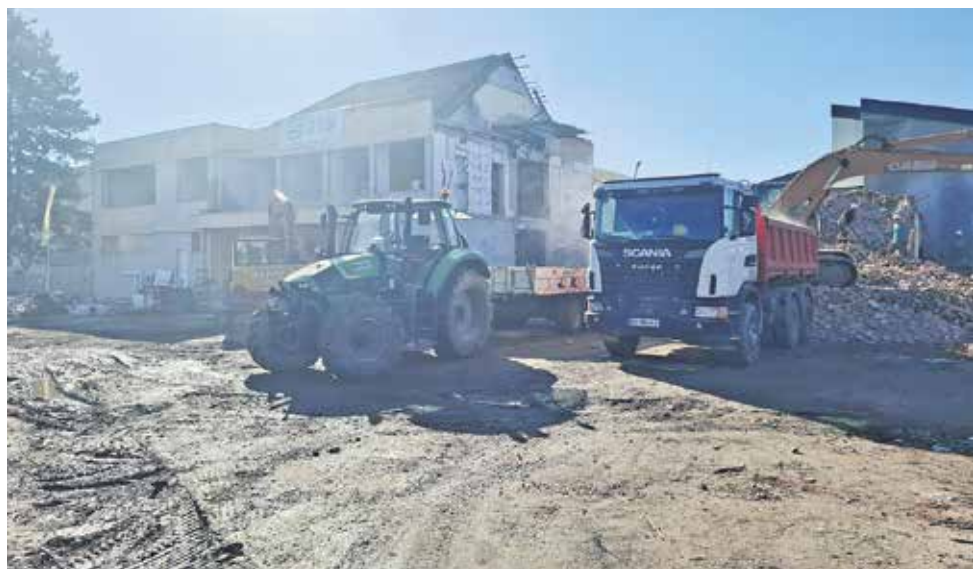
V Artičah se je začelo rušenje stare šole, namesto katere bodo zgradili novo (foto: Občina Brežice).
