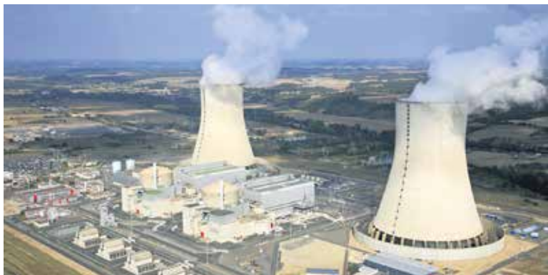
179 metrov visoka hladilna stolpa na naravni vlek v jedrski elektrarni Civaux (foto: EDF, Didier Marc)
