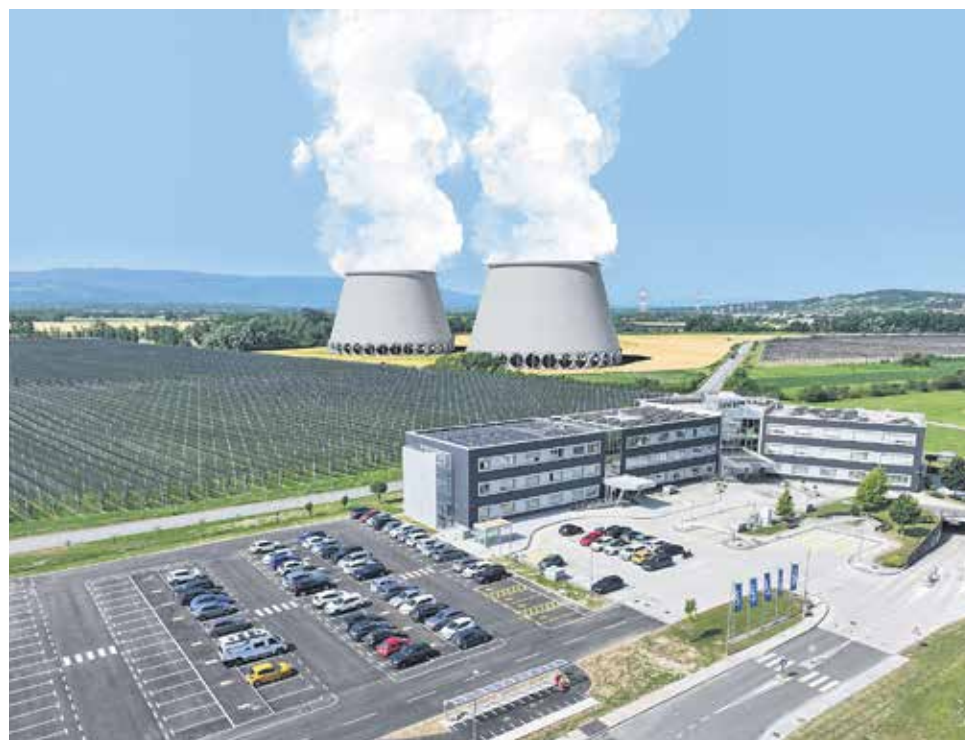
Stolpa s kombiniranim naravnim in mehanskim vlekom
