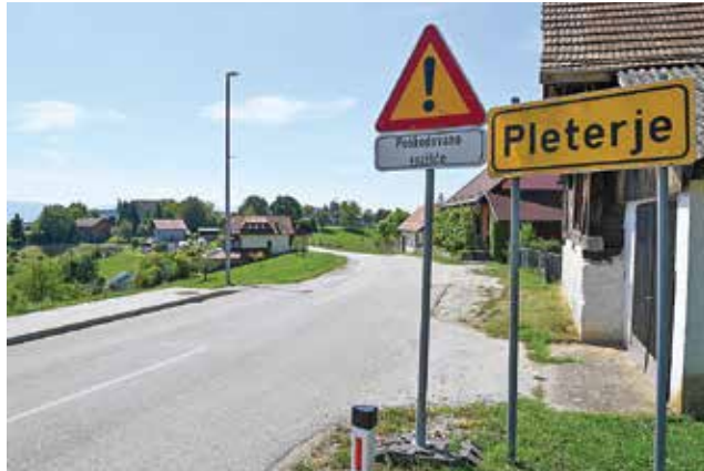
Rekonstrukcija državne ceste Zdole-Krško v dolžini 3.580 metrov se začne septembra.
