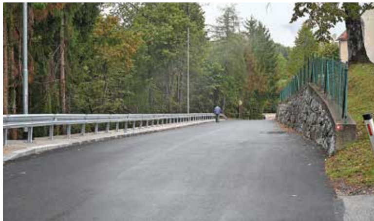
Novo urejen odsek lokalne ceste skozi Zabukovje
