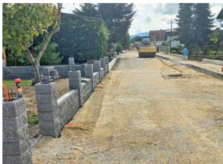
Črešnjice – zaključevanje del in priprava na asfaltiranje
