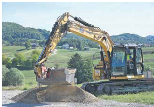
Simbolna otvoritev gradbenih del
