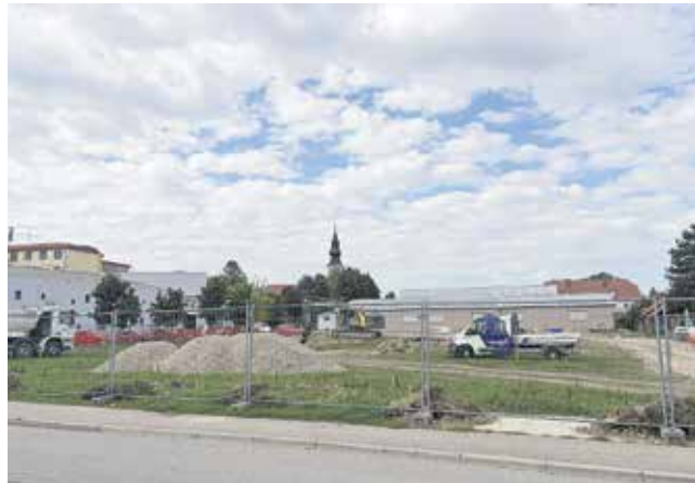
Gradbišče za novo parkirišče v Brežicah
