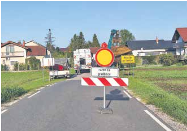
Začetek obnove ceste na Hrastju
