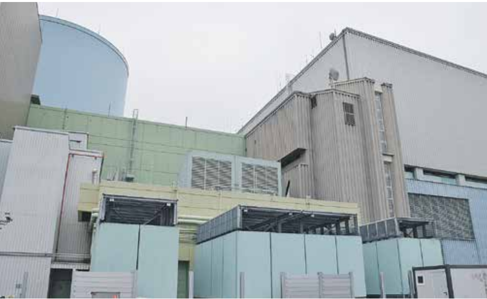
V okviru prilagoditev na podnebne spremembe so v elektrarni posodobili strelvodno zaščito in končali projekt protitočne zaščite zgradb tehnološkega dela.
