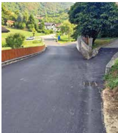
Modernizirana lokalna cesta Orehovec–Pišece
