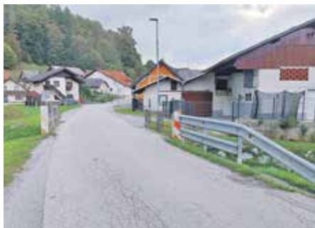
Most v Pijavica pred rekonstrukcijo
