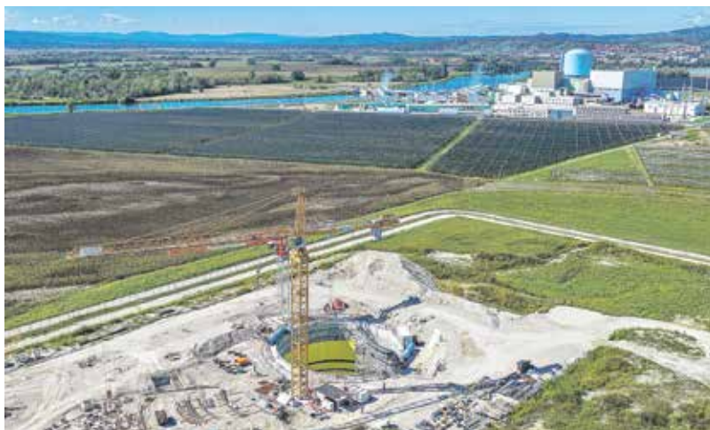
'Srce' odlagališča je odlagalni silos, kamor bodo prve radioaktivne odpadke iz bližnje NEK odložili leta 2028 (foto: ARAO).
