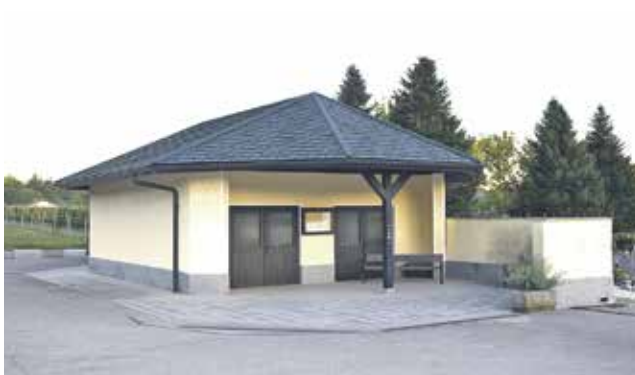
Poslovalna vežica ima novo streho, krajanke pa si želijo še nadstrešek na ploščadi pred njo ter obnovo odstopajočih talnih plošč.
