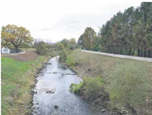
Na območju Rigonc je bil med drugim zgrajen visokovodni zid.
