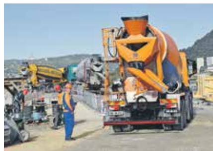
Na gradbišču je v tem času zelo živahno, 'hruške' betona se kar vrstijo ena za drugo.
