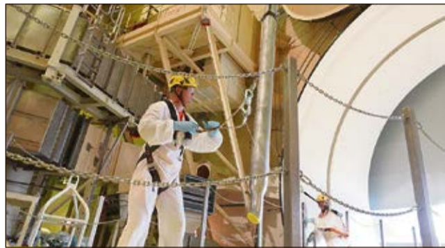
Vnos novega cevovoda v zadrževalni hram (foto: NEK)
