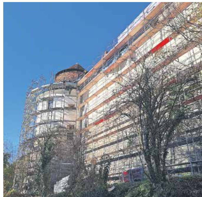
Potek obnove jugozahodnega stolpa brežiškega gradu
