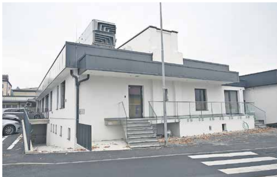
Preventivno-rehabilitacijski center Zdravstvenega doma Sevnica
