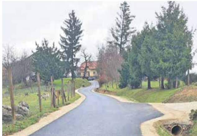
Moderniziran odsek lokalne ceste Globoko-Rovišče
